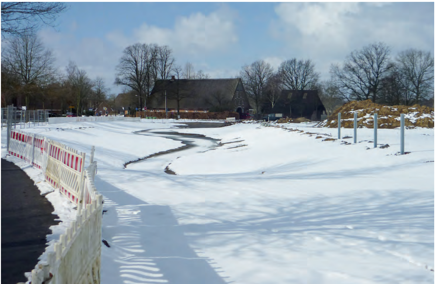
Das neue Regenrückhaltebecken an der Hauptstraße. Notwendiges Übel oder Blickfang?
